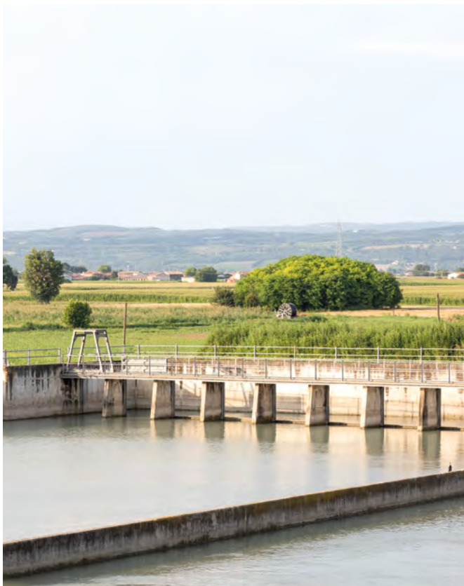
02. Water infrastructure system. Vasca di carico e sedimentazione lungo il fiume Guà, collegata tramite un canale sotterraneo al fiume Bacchiglione | Loading and sedimentation basin along the Guà river, connected to the Bacchiglione river through an underground canal. G. Miotto, A. Zaramella
