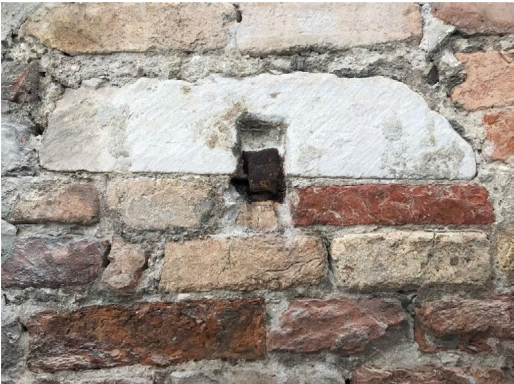
**2:** Esempio di legamento muratura – solaio, meglio noto come "fiuba". Nell'immagine si vede l'elemento metallico di connessione che si aggancia all'elemento in pietra d'Istria. Sestiere di San Marco, foto dell'autore, 2021.
