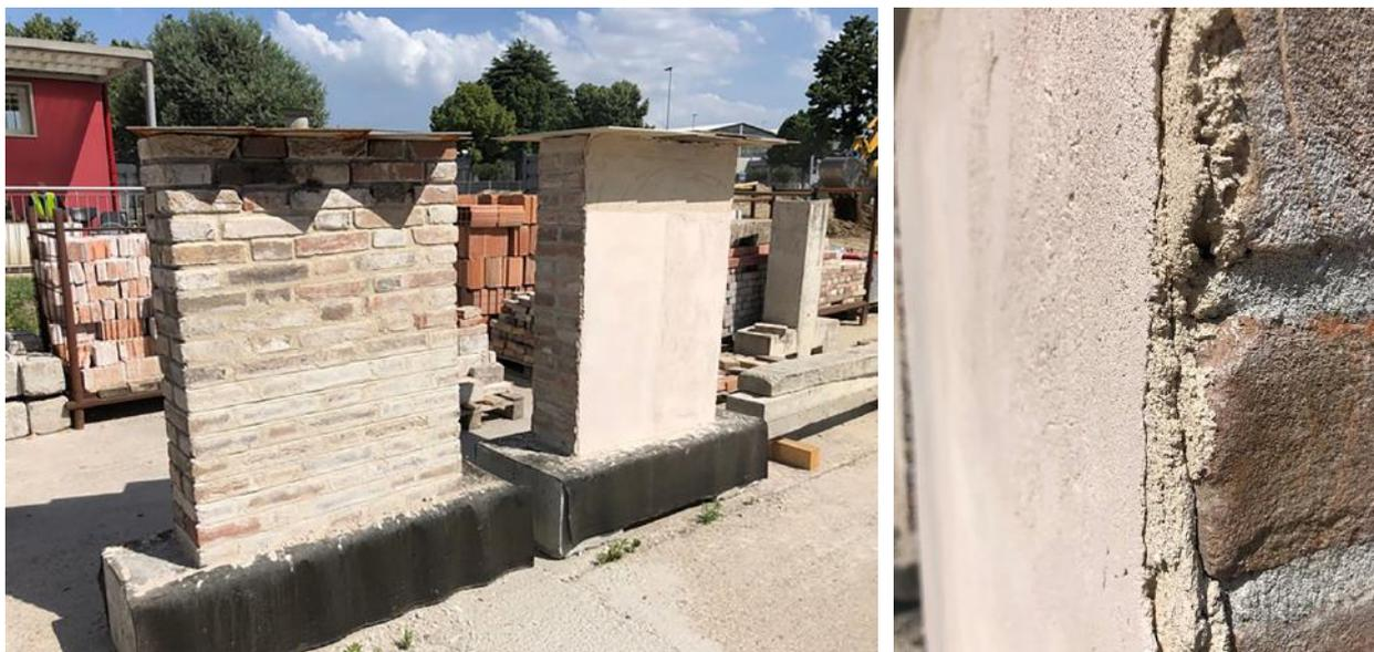
Figg.2-3 – Vista dei pannelli in fase di completamento e dettaglio degli strati
