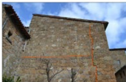
CF5 - Prospetto esterno sud-est
