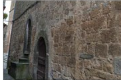
Prospetto esterno sud-ovest
