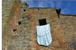
CF6 - Prospetto esterno sud-est
