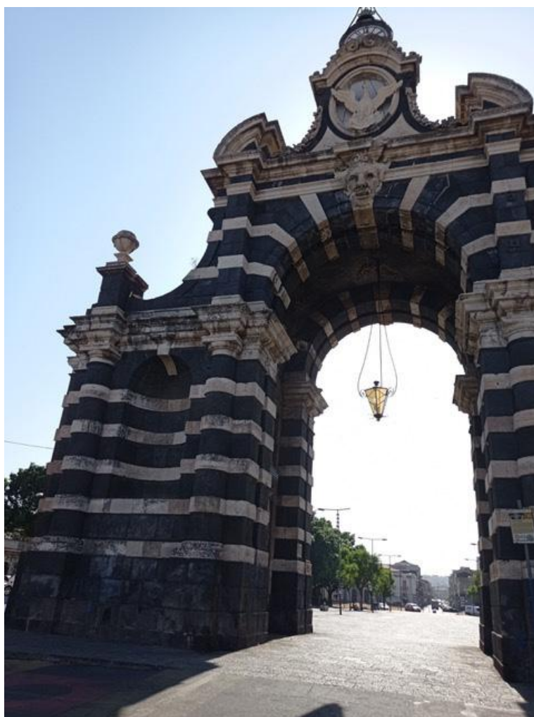
Figura 1. Porta Garibaldi (CT), costruita nel 1768 in occasione delle nozze di Ferdinando I delle Due Sicilie con Maria Carolina d'Asburgo Lorena. Particolare di atti vandalici sul laterale. Foto dell'autrice.
