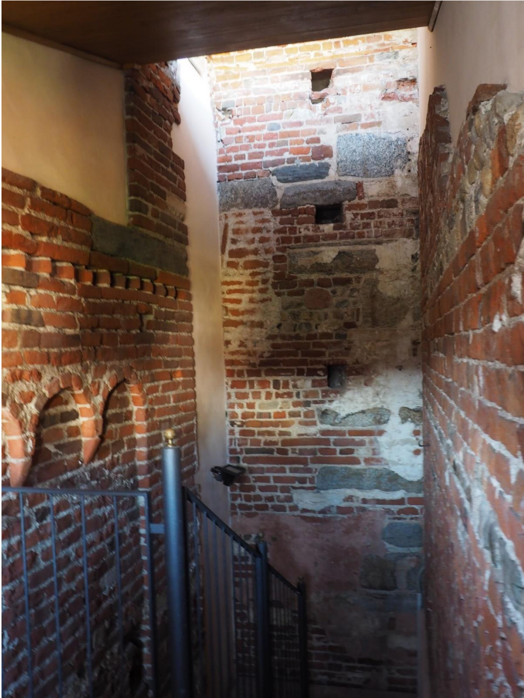
Figura 4.19. Testata orientale del transetto nord
