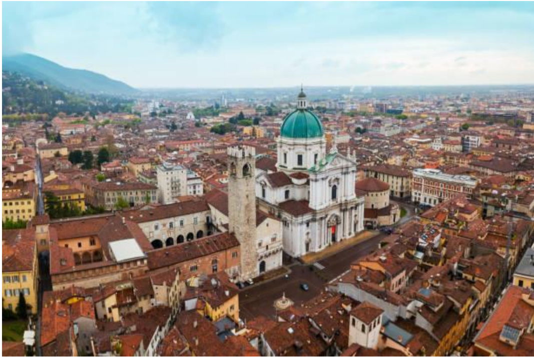
Figura 3.27. Veduta aerea dell'area delle cattedrali e del Broletto di Brescia
