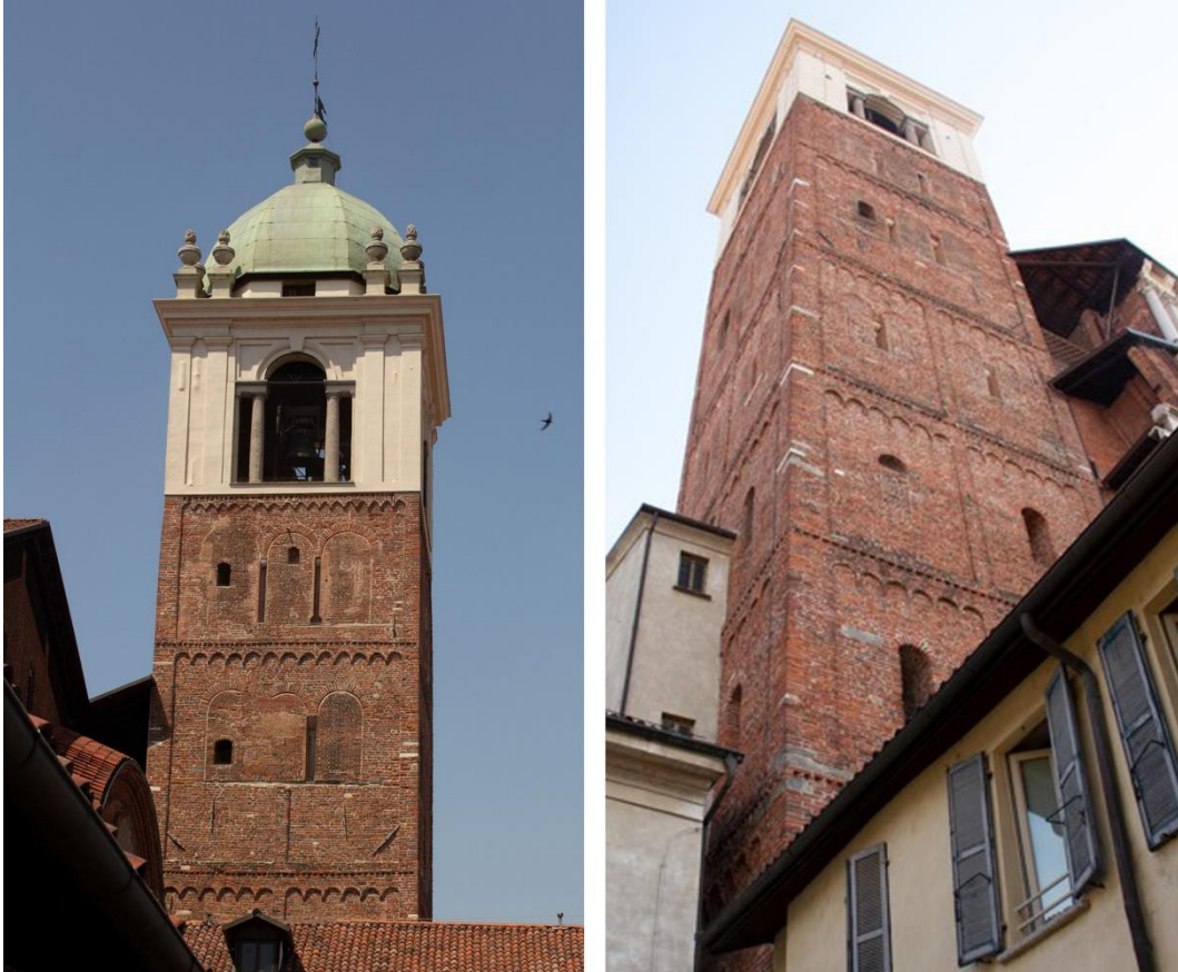
Figure 4.17 e 4.18. Il campanile della cattedrale di Novara di fronte e dal basso. Fotografie di E. Casarotti
