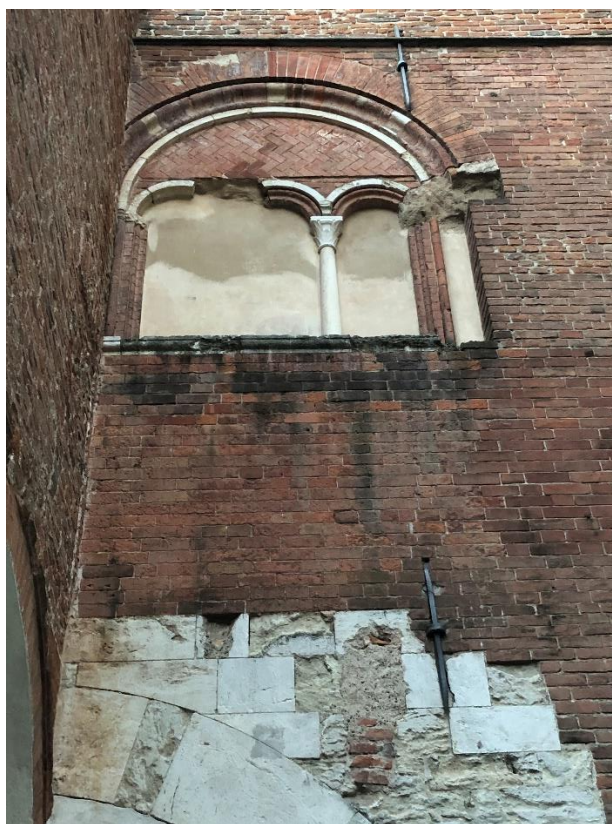
Figura 3.20. Particolare dei due livelli di elevato del palazzo comunale di Pavia (foto E. Casarotti)
