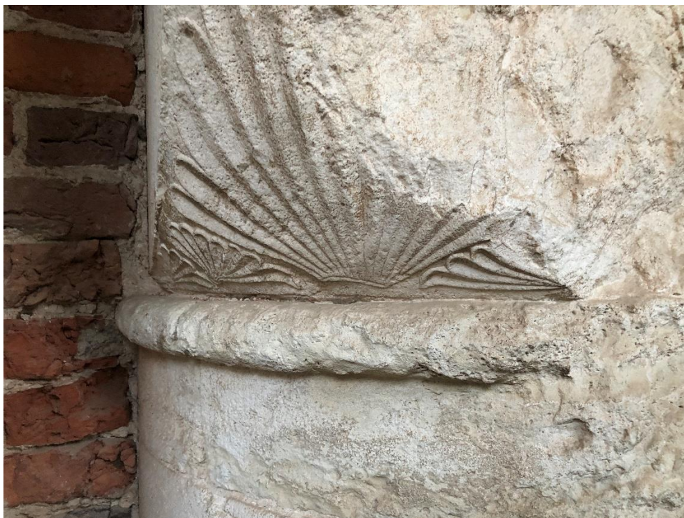
Figura 3.19. Particolare della decorazione di uno dei capitelli a cubo scantonato del porticato inferiore del palazzo comunale di Pavia (foto E. Casarotti)
