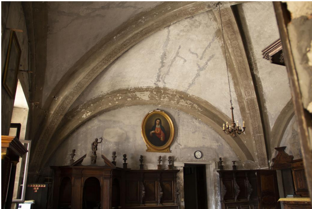
Figura 4.26. Volta a crociera costolonata della prima sala del palazzo di Litifredo (foto E. Casarotti)
