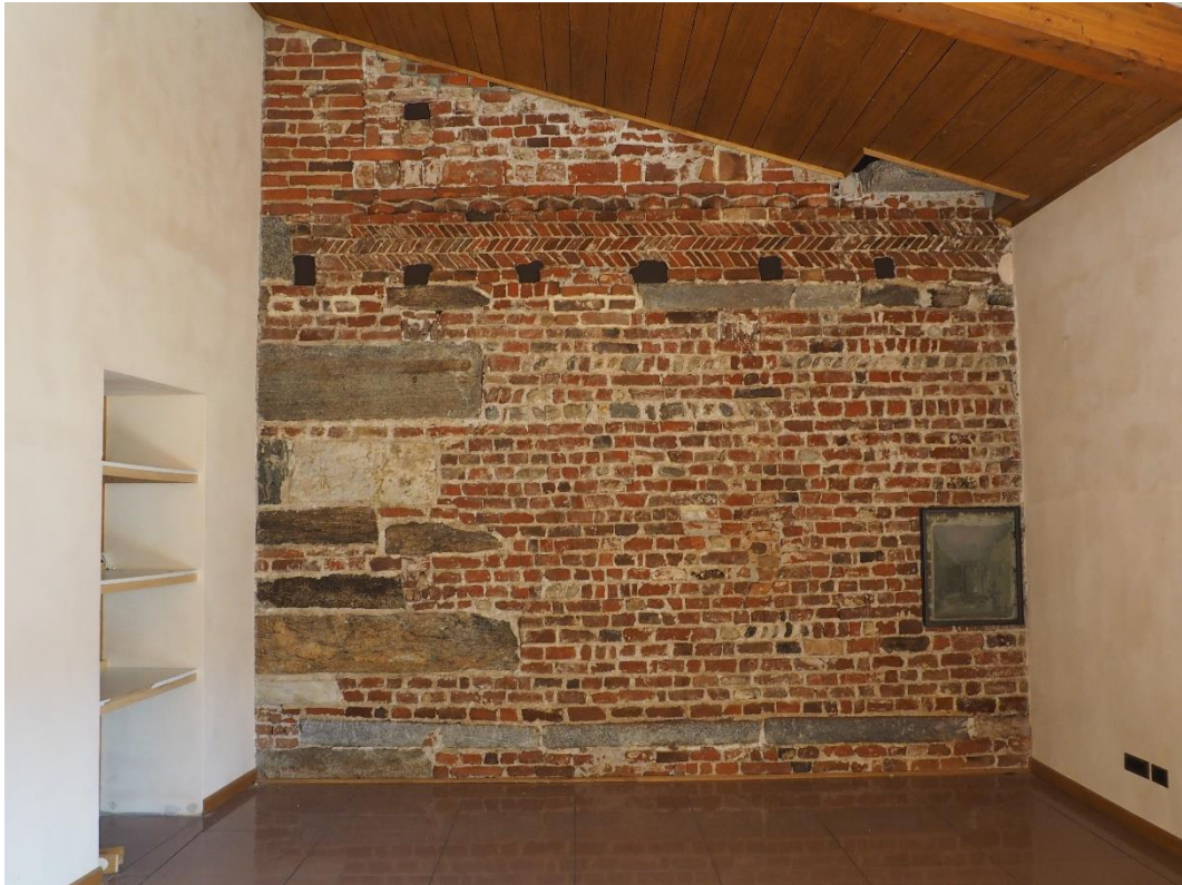
Figura 4.20. Testata settentrionale del transetto nord
