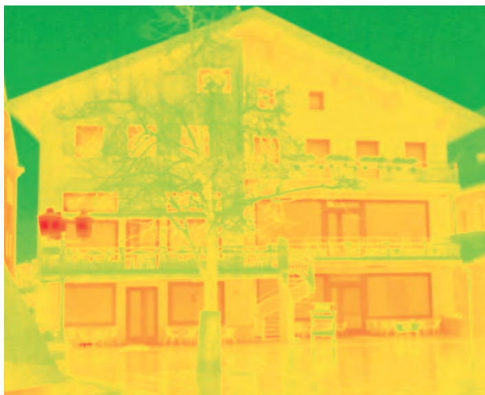
Fig. 2 - Immagine termografica di una facciata.
