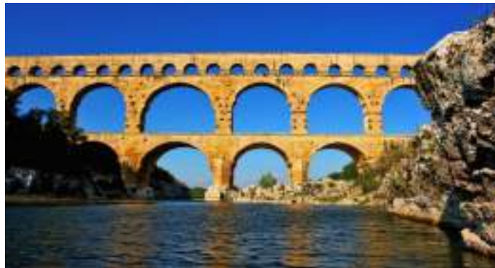
Fig. 2.8 Pont du Gard, Vers Pont du Gard, Francia.
