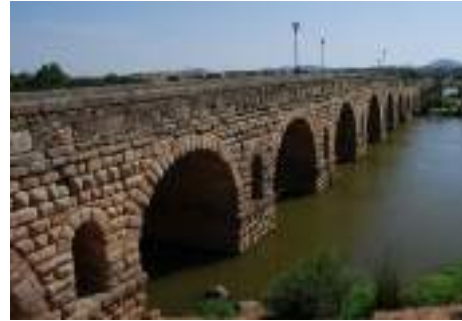
Fig. 2.14 Mèrida bridge, Extremadura, Spain.
