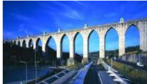
Fig. 2.32 Aqueduct delle Aguas Livres, Lisbon, Portugal.
