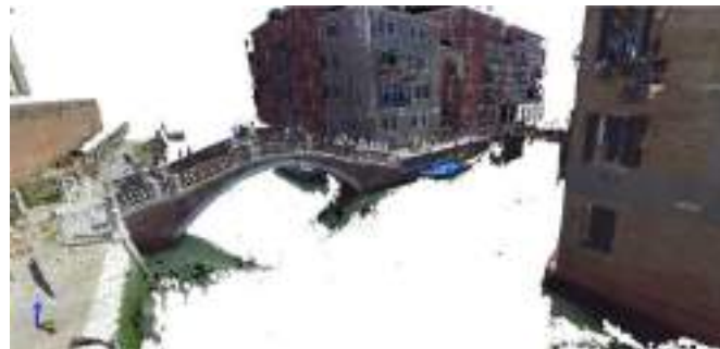
Fig. 8.3: "De L'Arzere bridge" Point cloud.
