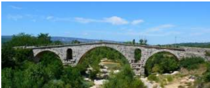
Fig. 2.26 Julien bridge, Bonnieux, France.
