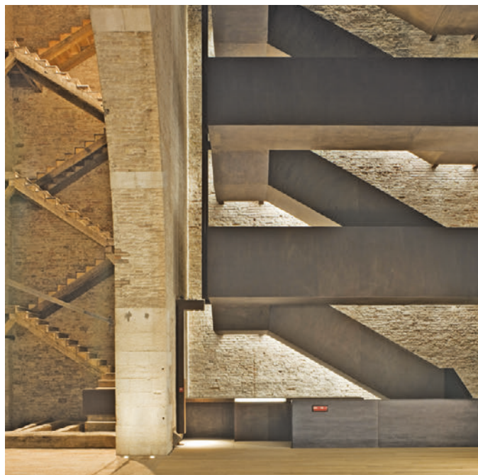
08 | Escalier intérieur en acier corten. Photo Alessandra Chemollo. Le scale interne in acciaio corten. Foto Alessandra Chemollo.
